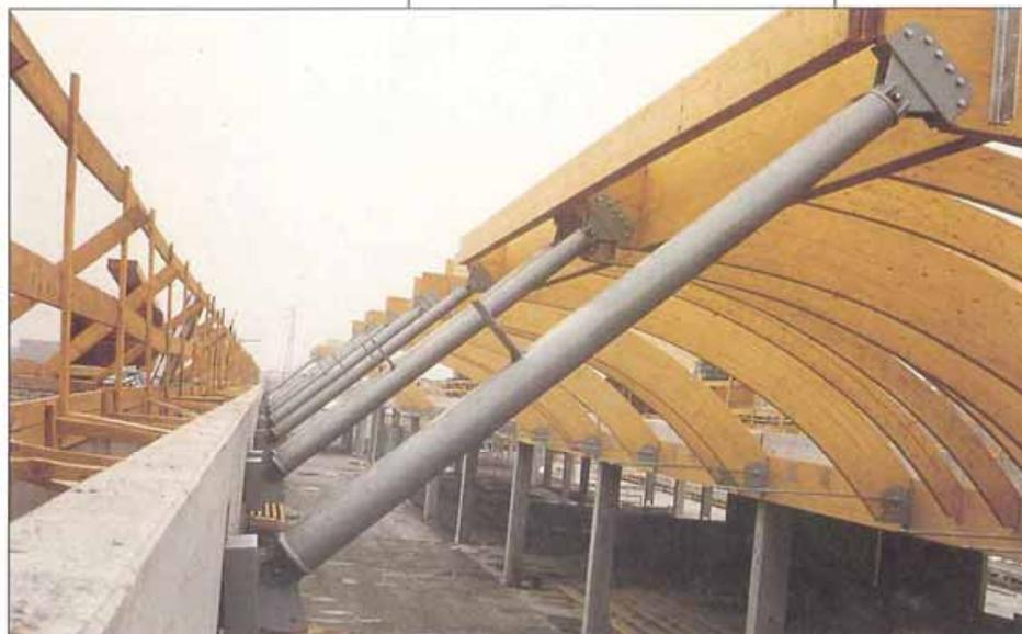
*in alto, particolare del nodo in acciaio di raccordo fra i pennoni in acciaio e le travi di copertura della piazza.
